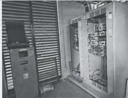
Riesgo de incendio por material inflamable por posible corto circuito en planta de energía eléctrica.
